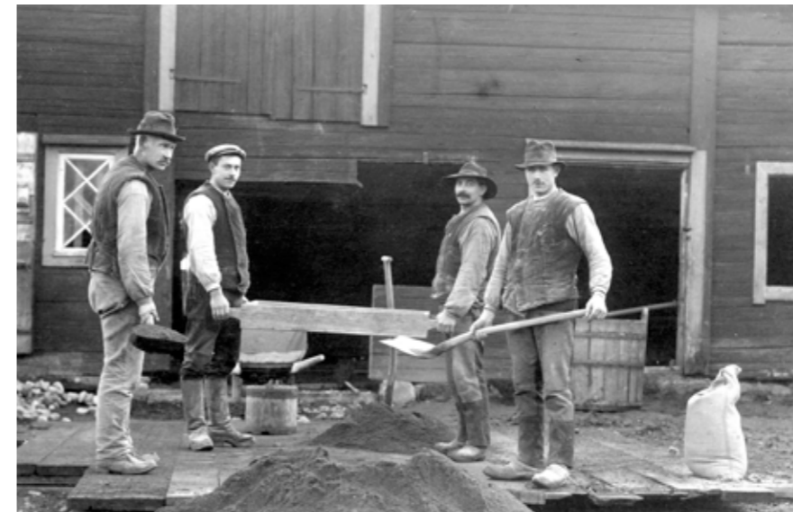
Göstas far och farfar sällar sand inför ett murningsarbete.
